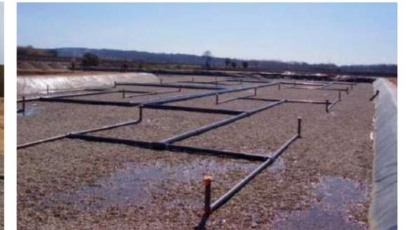
Estas canalizaciones se instalarán en la base del primer estrato instalando en el final de cada derivación el punto de alimentación a modo de canalización vertical de manera que las aguas a tratar se verterán a modo de fuente. Para evitar la erosión de la zona adyacente a cada punto de alimentación, se rellenará con grava (15/25) tal y como se muestra en la imagen adjunta a continuación.
